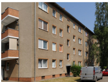
Abb. 5 Gebäude vor der Sanierung
