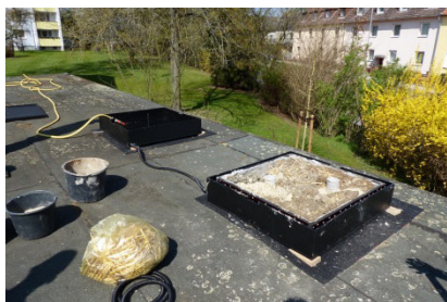
Abb. 3 Inbetriebnahme der Pfützenanlage
