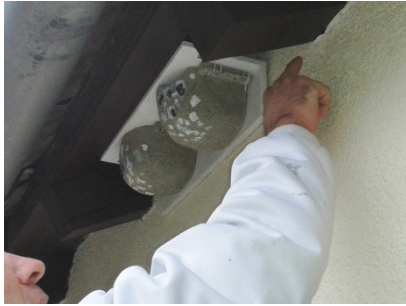
Abb. 27 Montage der Nisthilfe
