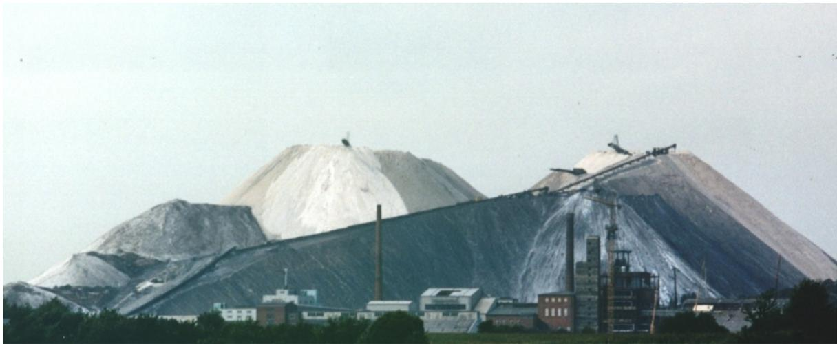
**Abbildung 1** –Werk Sigmundshall bei Wunstorf-Bokeloh. Rückstandshalden der Kaliwerke bestehen überwiegend aus recycelbarem Steinsalz.
