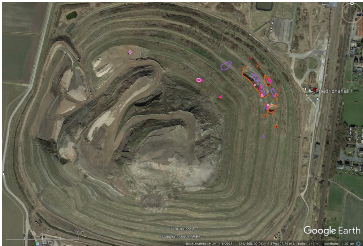
Abbildung 6 – Zahlreiche Erdfälle auf der in Abdeckung befindlichen Kalihalde Friedrichshall bei Sehnde. (Zusammengestellt aus Luftbildern ab 2010)
