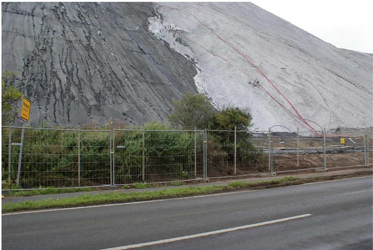
Abbildung 2 – Links: Typische Erosionsrillen durch fließendes Wasser in der REKAL-Abdeckung. Vordergrund: Provisorischer Zaun an der Durchbruch-Stelle. Aufnahme-Datum 02.09.2010.
