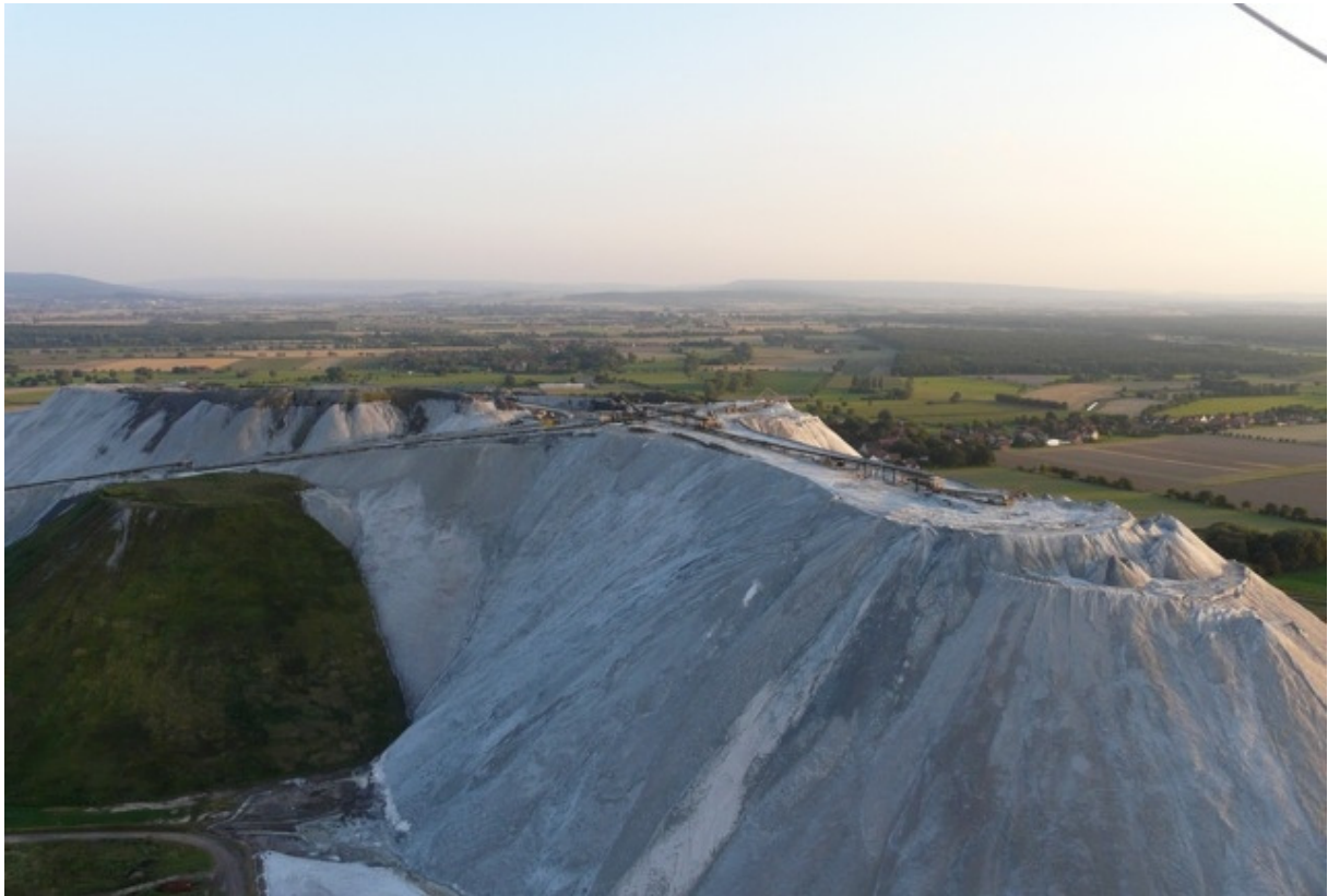
Abbildung 1 - Luftbild der Kalihalde Sigmundshall wenige Tage vor der Schlamm-Lawine. Man erkennt, dass auf dem Halden-Top kaum Platz für größere Pfützen vorhanden ist.
