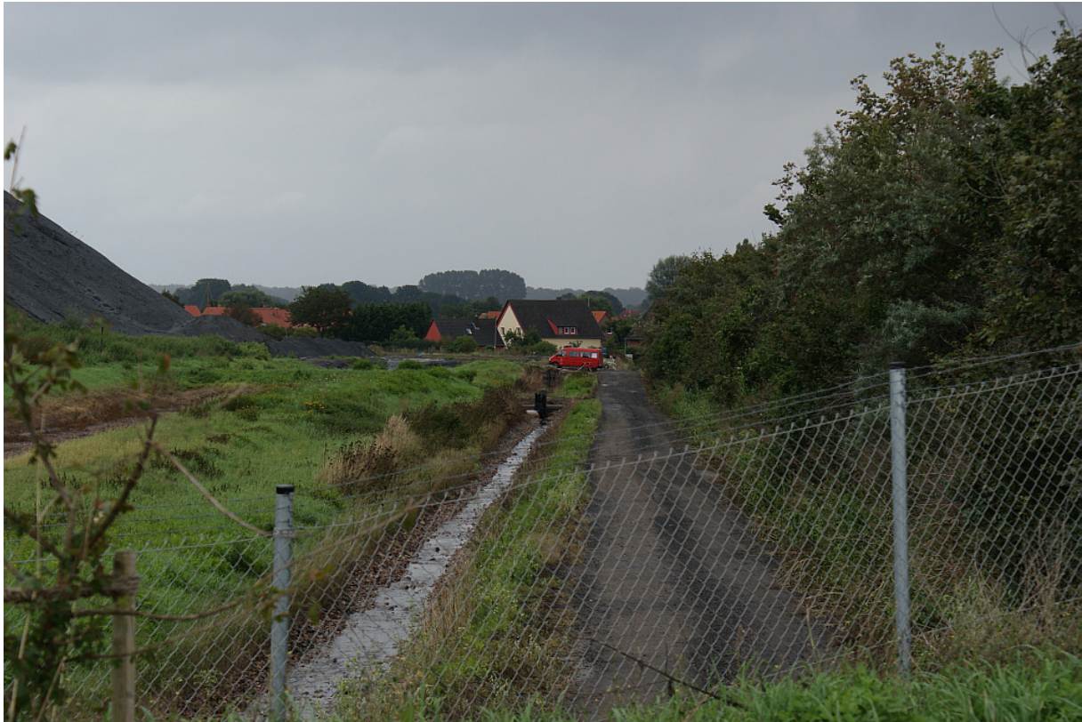
Abbildung 3 – Multi-Barrierensystem zwischen Kalihalde (links) und Kreisstraße (rechts hinter bewachsenem Erdwall). Die abgegangene Schlamm-Lawine hat sämtliche diese Hindernisse überwunden. Aufnahme-Datum 02.09.2010.
