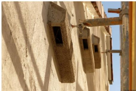
Abb. 22 Mauerseglernisthilfen - Bauphase
