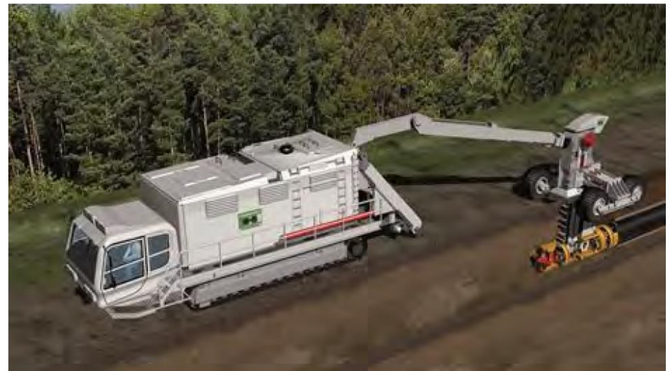
Abb. 8: Pipe Express-Verlegung eines Mantelrohres aus Stahl (halboffene Bauweise) (Quelle: Herrenknecht [2])
