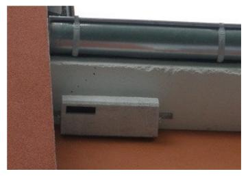
Strobel-Mauerseglernistkasten Nr. 420 (mit Montagewinkeln) B 45 x H12 x T16cm
