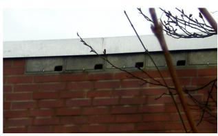
Nistkasten aus Ton für Ziegelwände B 36 x H 15,5 x T 15 cm www.gronenfelder-werkstaetten.de
