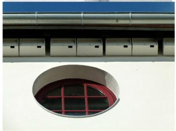
Schwegler Mauerseglerkasten Typ 17 C B 66 x H 15 x T 15 cm (mit Montagewinkeln)
