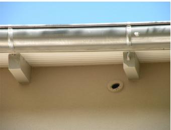
**1. bündige Platzierung** der Niststeine oder Quartiere in der Fassade oder dem WDVS mit Öffnung für Mauersegler seitlich (Foto), sowie Spalt für Fledermausquartier nach unten anordnen (Abbildungen)
