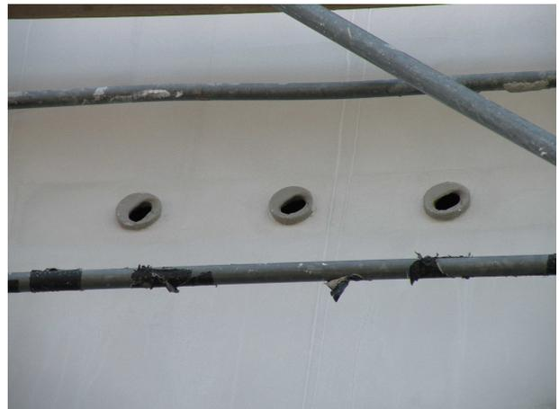
2. Niststeine an der Rückwand verkleben, schwere Kästen ggf. durch Dübel sichern, armieren und verputzen. Die Einflugöffnung steht je nach Putzstärke etwas hervor.
