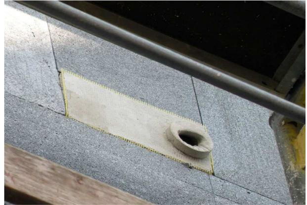
1. Niststein bündig in die Dämmung einsetzen, damit später kein Abdruck sichtbar ist, ggf. mit Isolierband versehen.
