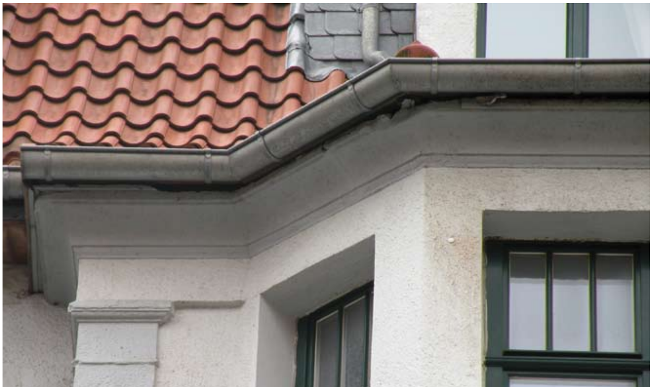
Erhalt von Einflugmöglichkeiten an der Altbaufassade
