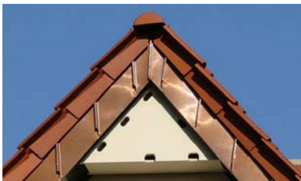
Nistkastenkonstruktion im Giebel
