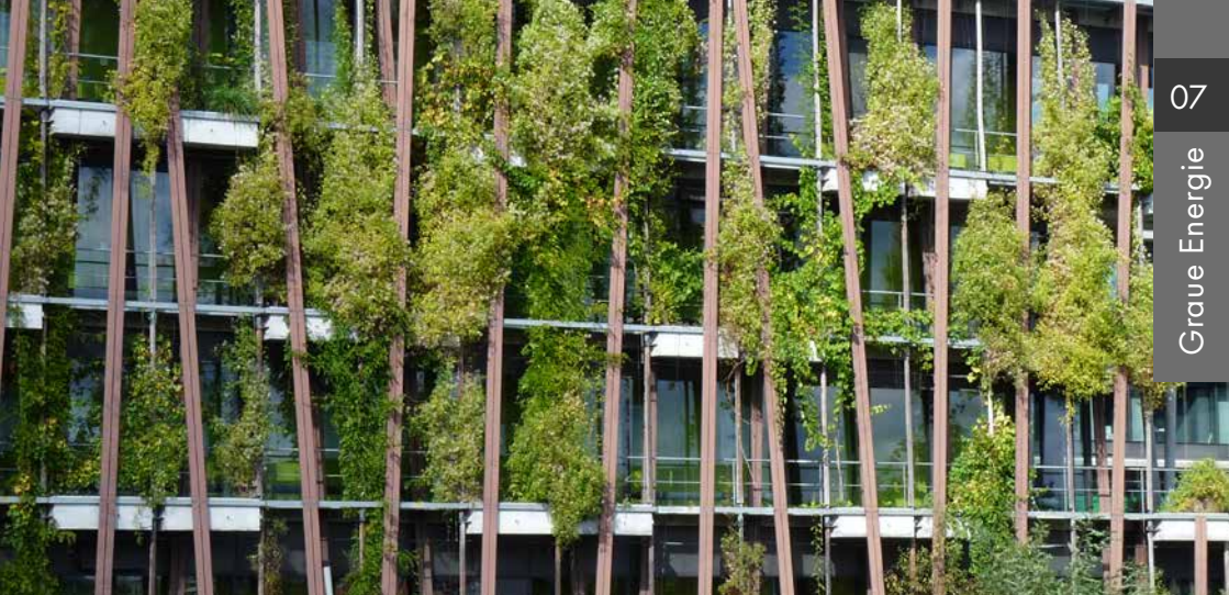
Die Begrünung an der Glasfassade vom Institut für Physik, ist Gebäudekühlung und aktiver Sonnenschutz in heißen Sommern. | Foto: Marco Schmidt
